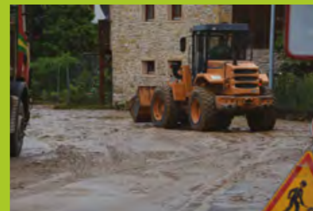
Coulées de boue du 8 juin 2016, rue du Stade Intervention des engins de déblayage
