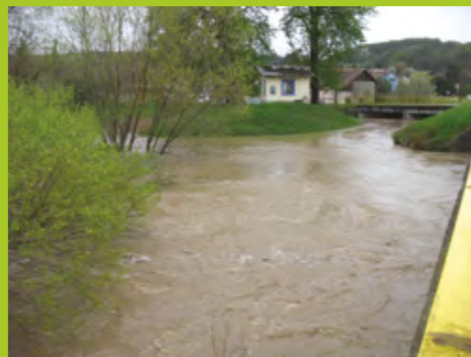
Les aménagements (comme le chenal de crue) ont permis de protéger les parties basses du village. (17/4/2016)
