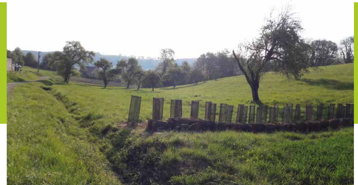
Plantation d'une haie destinée à freiner les coulées de boue dans le prolongement de la rue de la Forêt
