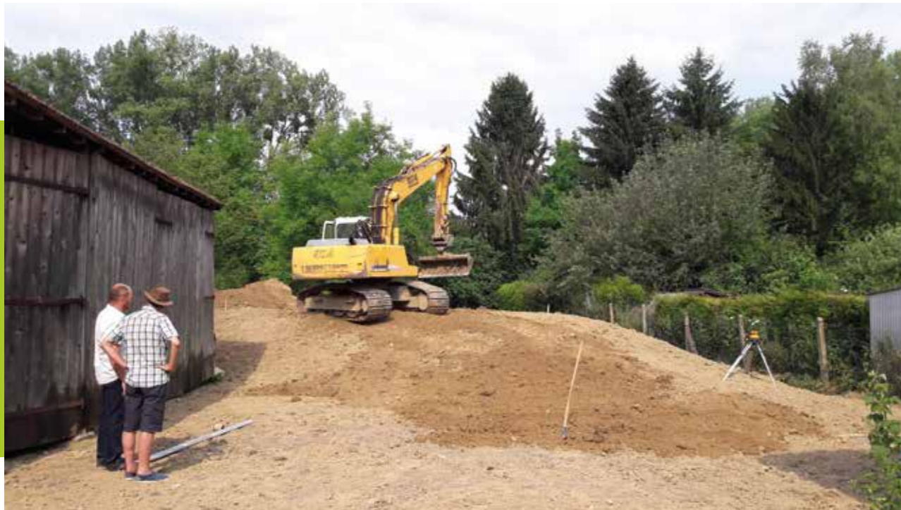
Prolongement de la digue existante rue de Wittersdorf
